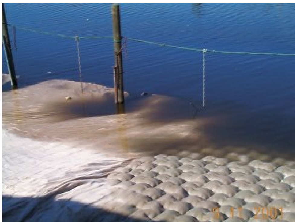
מילוי מזרוננים לייצוב קרקע על שפת נחל הירקון - הדר מערכות בע"מ
