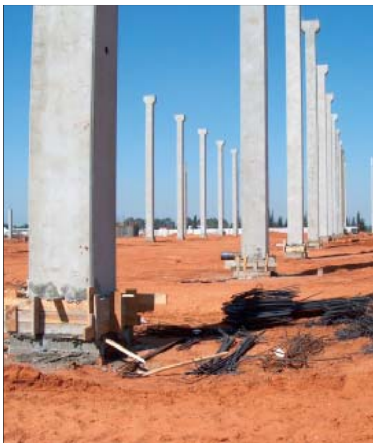
מתחם קרית שדה התעופה - יישום בטון מפוצה התכווצות לדיסק עמודים - מבנה תמ"מ בע"מ
